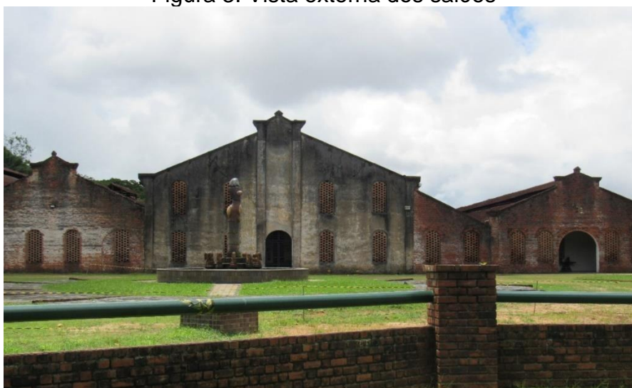
Figura 3. Vista externa dos salões
