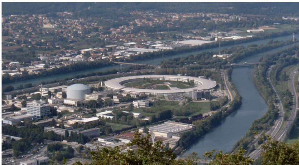
Figura 14 - Instalação da ESRF em Grenoble – França.
